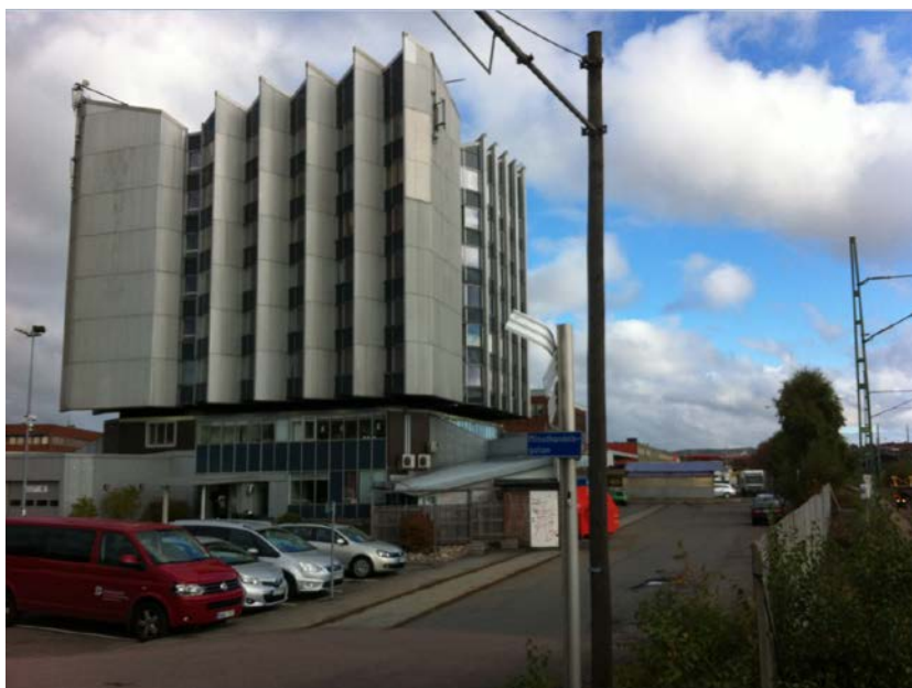
Byggnaden inom fastigheten Olskroken 35:17.
